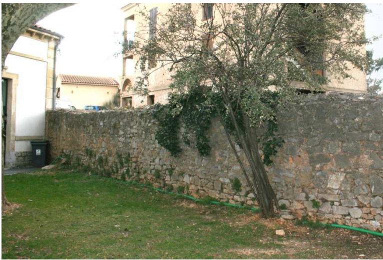
Illustration 10. Cour nord, mur de clôture, Karyn Orengo, 2013.
