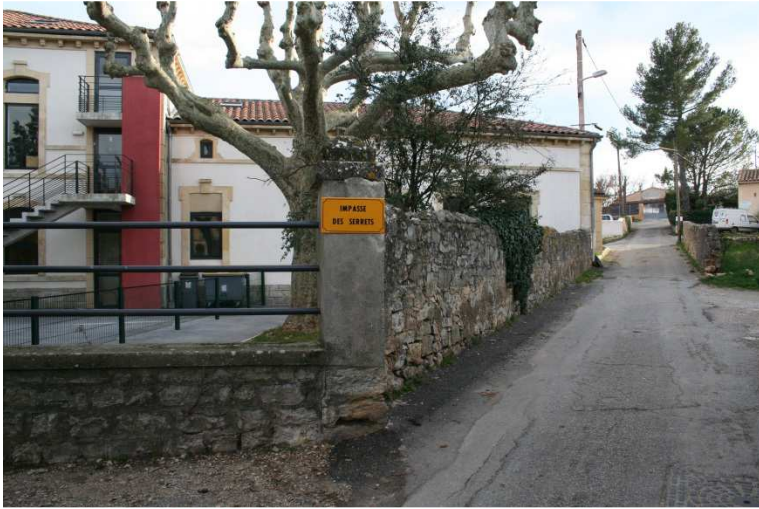
Illustration 9. Place Jules Ferry, mur de clôture, Karyn Orengo, 2013.
