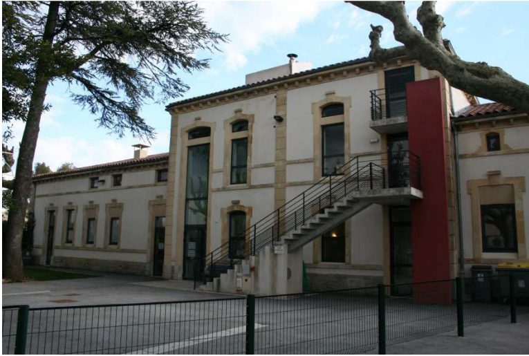
Illustration 3. Élévation sur cour, corps de bâtiment central et aile ouest, Karyn Orengo, 2013.
