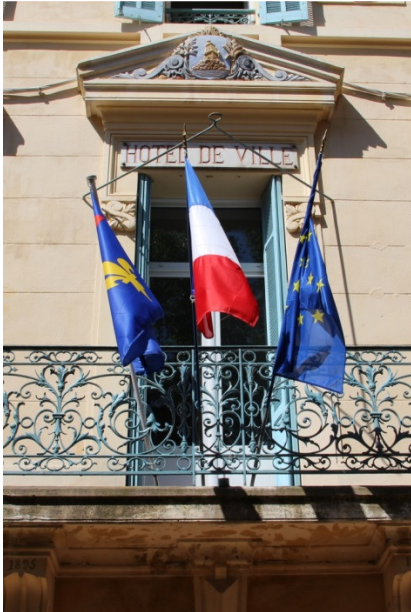
Illustration 3. Elévation principale, 1 er étage, fenêtre centrale, Karyn Orengo, 2013.
