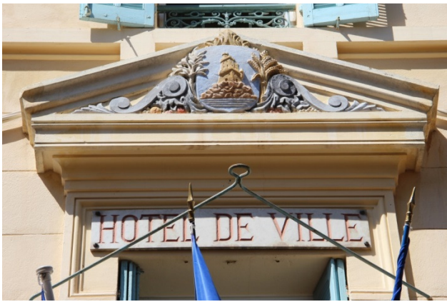
Illustration 4. Elévation principale, 1 er étage, fenêtre centrale, fronton, Karyn Orengo, 2013.
