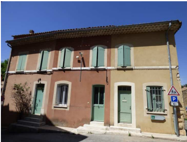
Illustration 34. Groupe scolaire de Pontevès, élévation rue des Puits, 2015.
