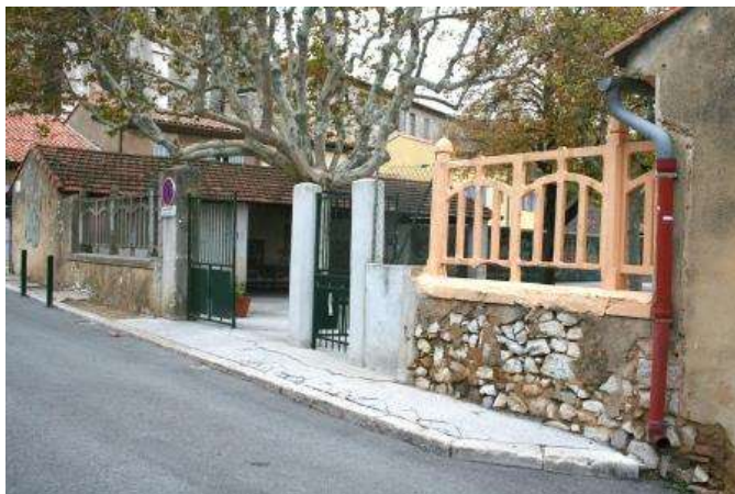
Illustration 17. Cour sud, mur de clôture, 2013.
