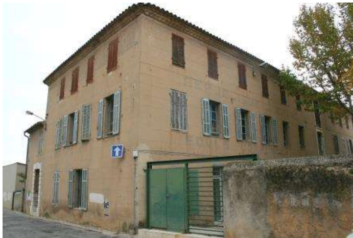
Illustration 9. Elévation latérale, ancienne entrée des garçons, 2013.
