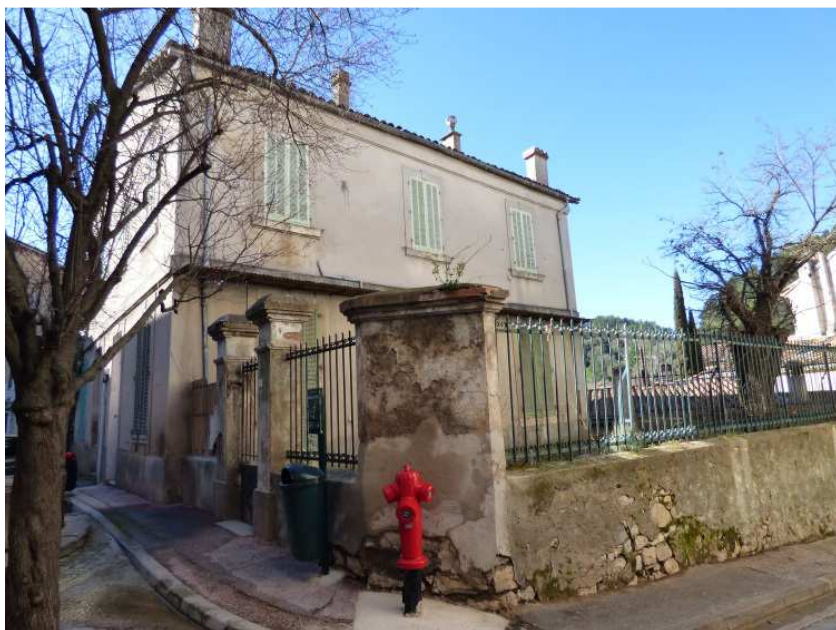
Illustration 13. Ancien groupe scolaire (entre 1904 et 1950), place des Anciennes Ecoles.
